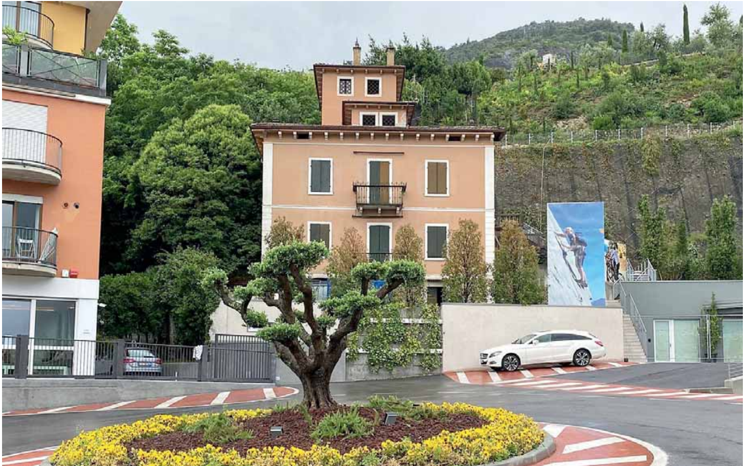
• Il cantiere edile a Villa Maria di Arco dove gli agenti della polizia locale hanno trovato una serie di difformità
